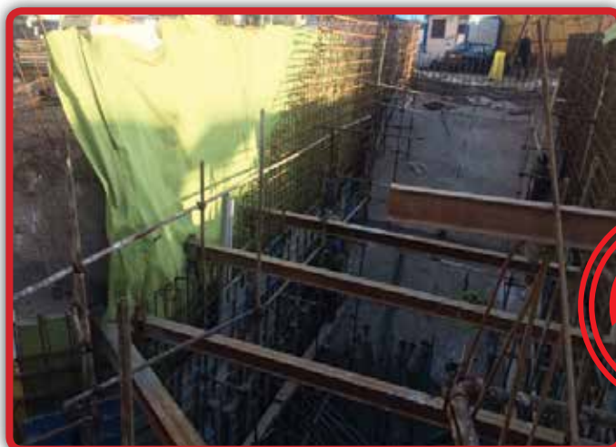
اجرای عایق ژئوممبرین و تکستایل و پارگی و شکم دادگی به دلیل شرایط سخت نصب عایق
