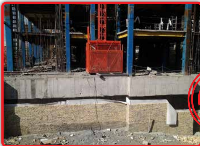
اجرای عایق ایزوگام، اجرای فوم و اجرای دیوار آجری جهت حفاظت از ایزوگام
